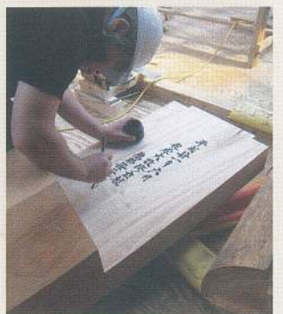
修理記を残す／丸柱を継木補修する際継手面にこの修復工事に関わった職人たちの名前を寄せ書きました。次回の解体修理の時まで、ふたたび見ることができない。
