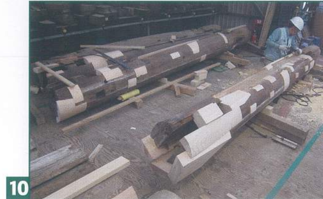
10 再用部材の補修／丸柱30本の内、1本だけ移築時に取替えられていた。今回は、もう1本取り替えて、残り28本は修理して再利用した。
