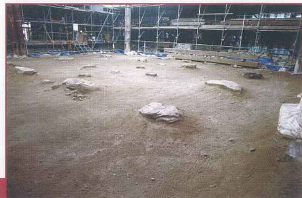
8 本堂解体完了 礎石・床下叩きの様子／礎石表面は、被焼した跡が見られる礎石と、丸柱圧痕が残る旧興隆寺礎石10個に分けられた。
