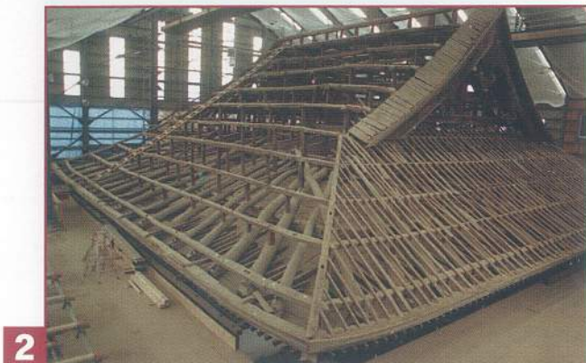
2 屋根の解体／棧瓦を取り外し、屋根廻りの雨漏りや腐朽による補修箇所を調査していく。
