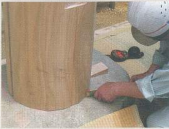
継木／長手方向に継ぎ足す修理方法はひとつ。剛性が必要な継木には金輪継ぎを選択するなど、各用途に応じて特徴のある継木の形が編み出されている。
