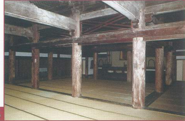
5 解体前の本堂(外陣より見る)／視界をさえぎる建具類は無く、広々とした畳敷きの堂内奥方に須弥壇を構える。
