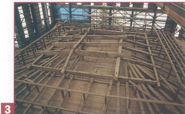
3 小屋組の解体／棟木や母屋等の小屋組材を解体していく。大梁材4本の内、旧興隆寺材2本が転用されていた。
