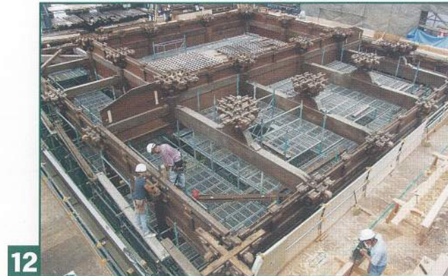
12 斗拱の組立／潰れた大斗は、別木補修して再利用した。移築時に付した番付から、旧取付場所が判ったものは元の位置に戻した。
