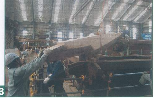
13 化粧間木の組立／母屋材に転用されて残る旧化粧間木材2本は、補修して再利用し、足りない2本を造り直した。
