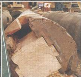
埋木／補修技法のひとつ。狭く・深い腐朽内部を掘り取り、新しい部材を埋めて修理する。
