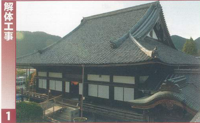
1 解体前の本堂(外観)／昭和32年(1957)の屋根葺替工事で、傷んだ棧瓦の補修と降り棟や鬼瓦の整備を行っている。
