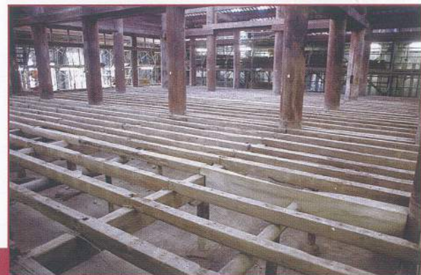
7 床板・根太の解体／床板を解体すると、根太以外に敷鴨居材や造作材が転用されていた。
