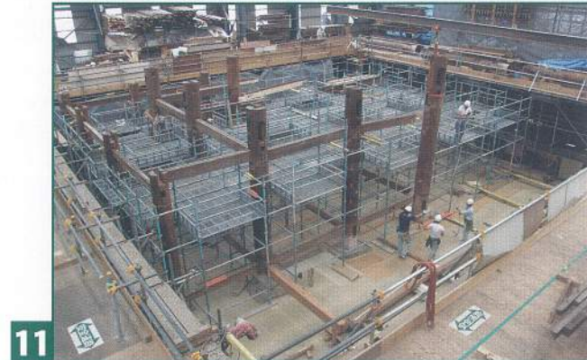
11 軸部の組立／大引・足固材の継手・仕口から組立順を決め、丸柱を礎石上に建て並べていく。
