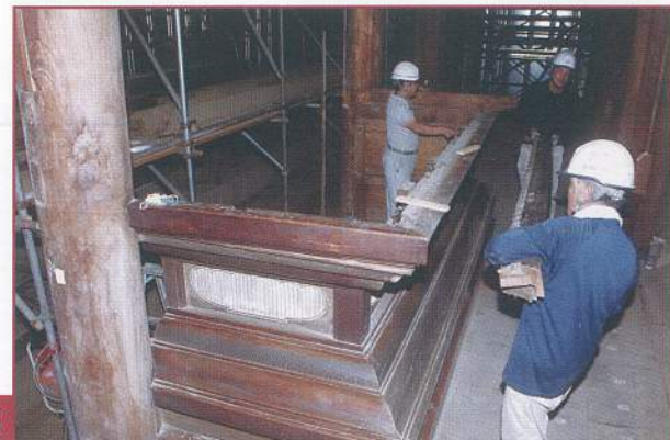
6 須弥壇解体／須弥壇は檜材で造られている。書き込まれた番付により、旧興隆寺材を転用して造られていることが判った。
