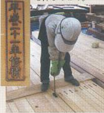
焼印を押す／再利用した部材と、今回の修復時に取替・補足した部材を区別するため、修理年号を記した焼印を押しておく。
