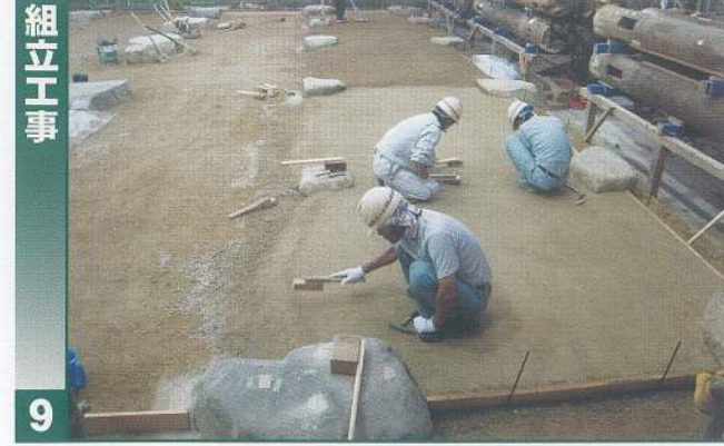
9 礎石据直し・土間叩き直し／旧興隆寺礎石は再利用、被焼した礎石は新たに取替えた。その後、床下土間叩きを行った。
