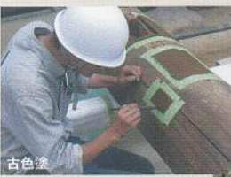
古色作業／取替・補修した部材の表面仕上げとして古色塗のほか、新しい木肌をガスバーナー等で焼き付ける方法がある。表面を炭化させたあと、タワシ等で磨き上げ木目を浮き出させる手法で3mmほど擦って100年程度古く見せられる。
