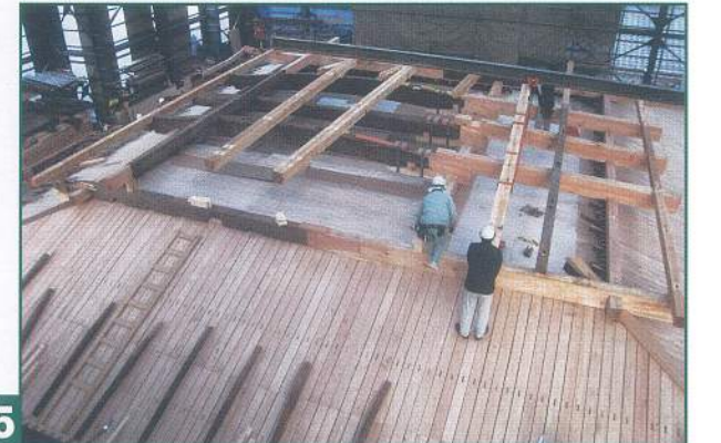
15 小屋組組立／旧興隆寺の大梁材3本は、長さが短く切られていたため継木補修して再利用した。
