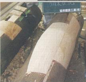
剝木／広く・浅い腐朽表面を削り取り、新しい部材で張っていく技法。造作材等の目目に付きやすい部材を再用するために行う技法で、大工の腕の見せどころである。
